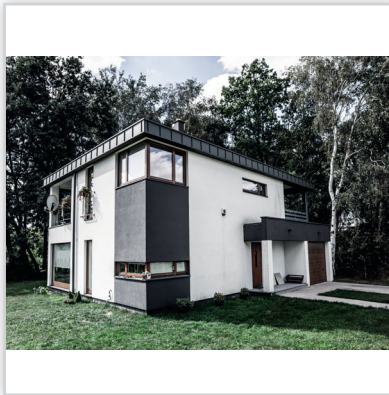
Osiedle domów jednorodzinnych w technologii szkieletowej w Solcu koło Konstancina. Autorem projektu jest arch. Joanna Fischer.
