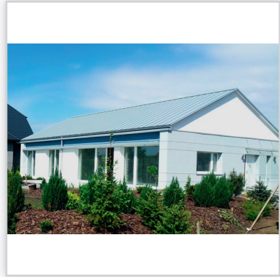
Dom pasywny. Dom w technologii murywanej w wersji pasywnej, certyfikowany przez Polski Instytut Budownictwa Pasywnego i Energii Odnawialnej uprawniony przez Passivhaus Institut w Darmstadt. Autorem projektu jest arch. Cezary Sankowski.
