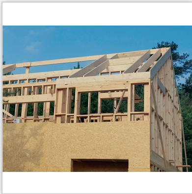
Konstrukcja szkieletowa. Lekki, drewniany szkielet jest niezastąpiony tam, gdzie dopuszczalne obciążenia wykluczają inne technologie.
